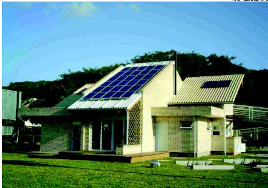
A Casa Eficiente mostra o uso racional da energia e menor impacto ambiental
