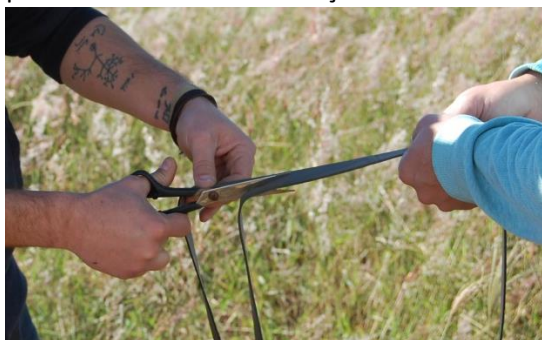
Corte da borracha de câmaras de pneu de caminhão em tiras, usadas para amarração das peças de bambu.
