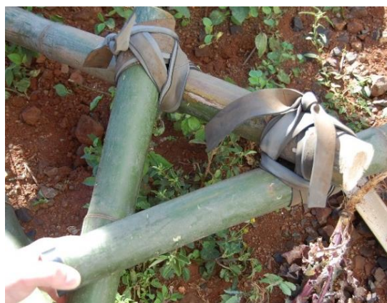
Disposição inicial dos colmos na montagem de um elemento triangular e amarração com tiras de borracha e nós.
