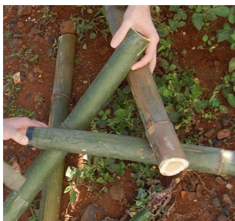
Disposição inicial dos colmos na montagem de um elemento triangular e amarração com tiras de borracha e nós.
