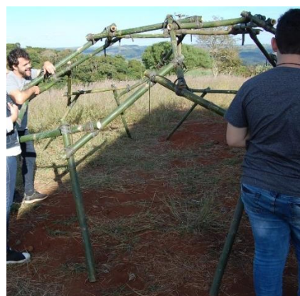
Segundo e terceiro nível da estrutura, construção de pentágonos e hexágonos regulares.
