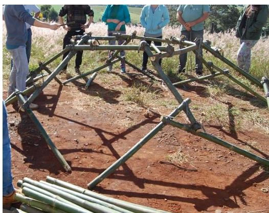
Segundo e terceiro nível da estrutura, construção de pentágonos e hexágonos regulares.
