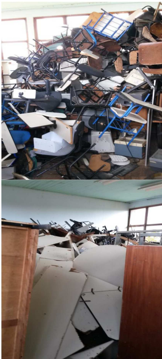
Figura 54 - Acúmulo de bens inservíveis em sala do CEFA 03
