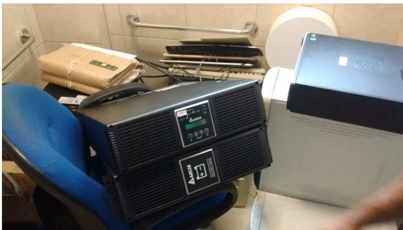
Figura 75 - Ponto de acúmulo em banheiro de deficiente físico - INE
