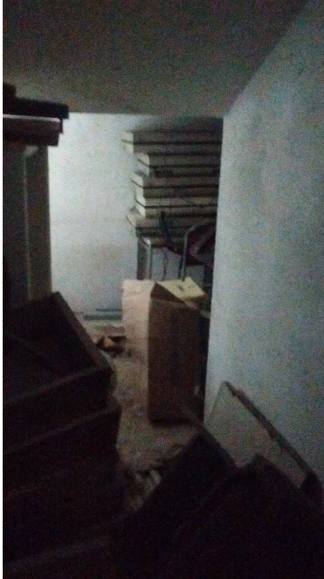
Figura 63 - Ponto de acúmulo isolado embaixo das escadas - ECV
