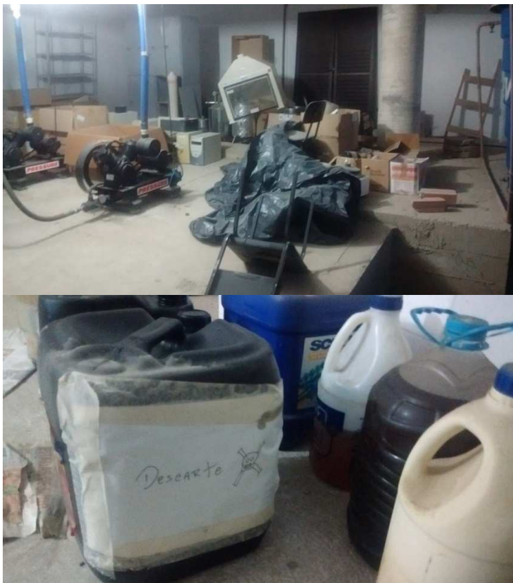
Figura 55 - Ponto de acúmulo embaixo do prédio da Engenharia Química, presença de resíduos químicos.
