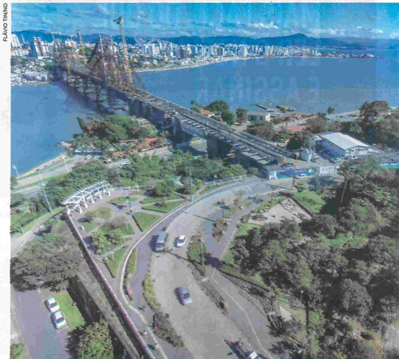
Um dos principais desafios de mobilidade é o acesso/saída na cabeceira insular, que fica em frente ao Parque da Luz
