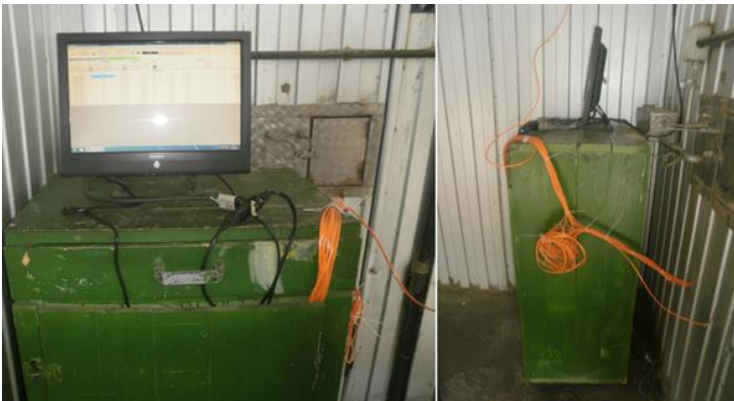
Figura 4.9 – Instalação de equipamento para aquisição de dados.
