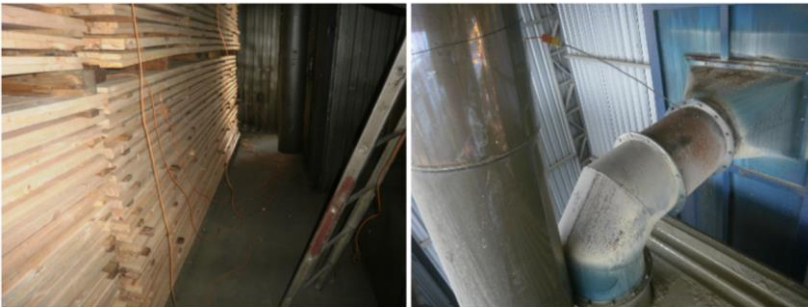
Figura 4.3 – Pilhas de madeira (esquerda) e chaminé de saída dos gases de combustão (direita).
