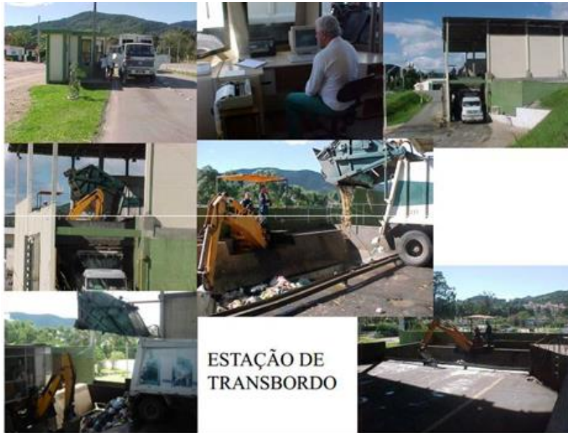
Figura 15 – Imagens da Estação de Transbordo do Centro de Transferência de Resíduos Sólidos (CTRe'S), 2009.
