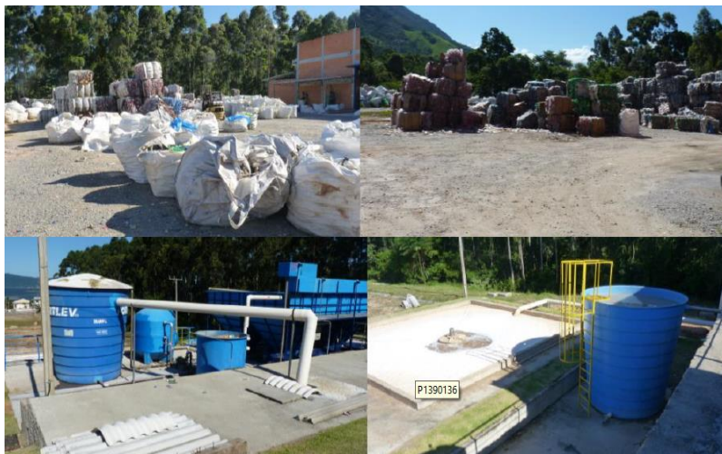
Figura 39 – Pátio: depósitos (frente e fundos), coletora de água da chuva e ETE da Indústria A.
