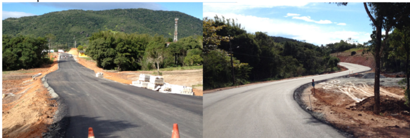
Ilustração 58 - Obra do PAC2 na Rua Padre Rohn em Santo Antônio de Lisboa
