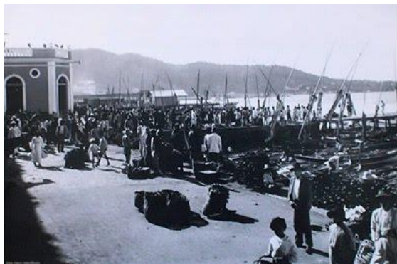
Figura 37: Três momentos que mostram as relações estabelecidas na borda d' água antes do aterro: na praça do mercado com a chegada dos barcos de peixes, movimentação no estaleiro Arataka (1932), competição de remo na região da Prainha, próximo ao Forte da Santa Bárbara.
