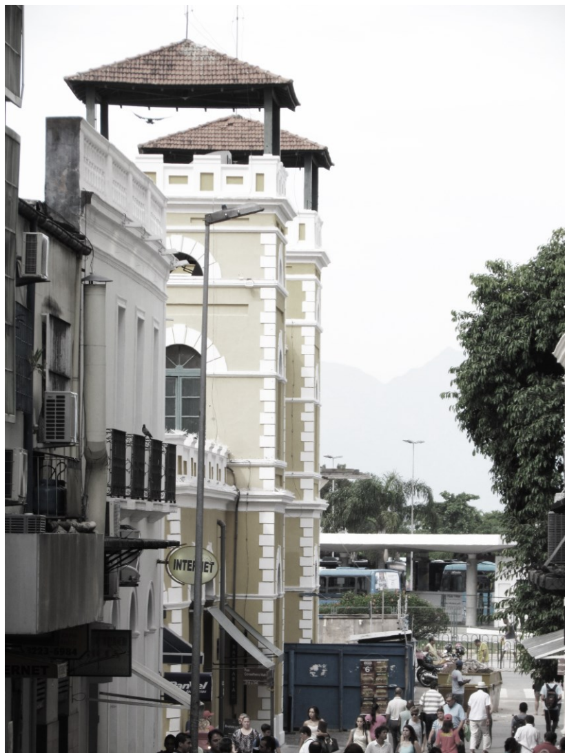
Figura 27 – Vista das torres do Mercado Público Municipal a partir da Rua Felipe Schmidt.
