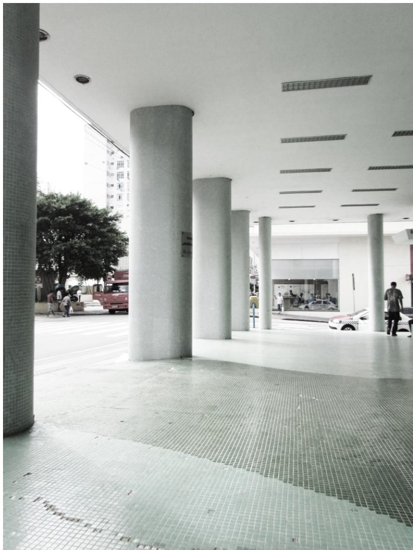
Figura 30 – Pilotis no nível do passeio no prédio da FATMA.
