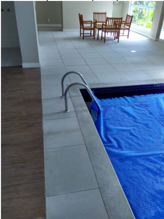
Figura 15 - Escada impede acesso à piscina por idosos– Cond. “A”.
