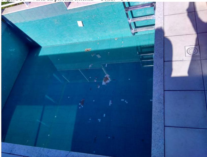
Figura 39 - Vista da piscina externa – Cond. “C”.
