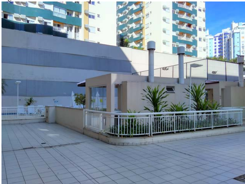
Figura 24 - Acesso à área de piscina - Cond. "B".
