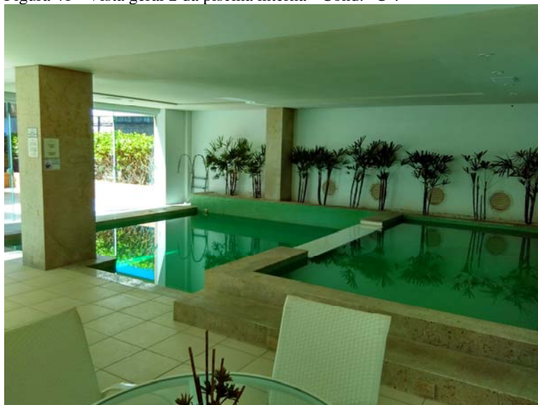
Figura 41 - Vista geral 2 da piscina interna - Cond. "C".
