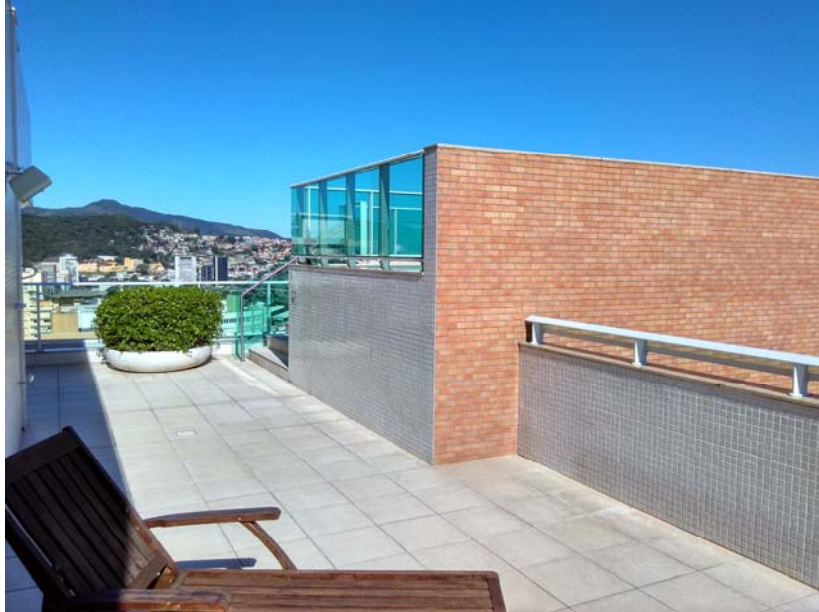
Figura 45 - Piscina externa: isolamento das demais áreas coletivas – Cond. “C”.
