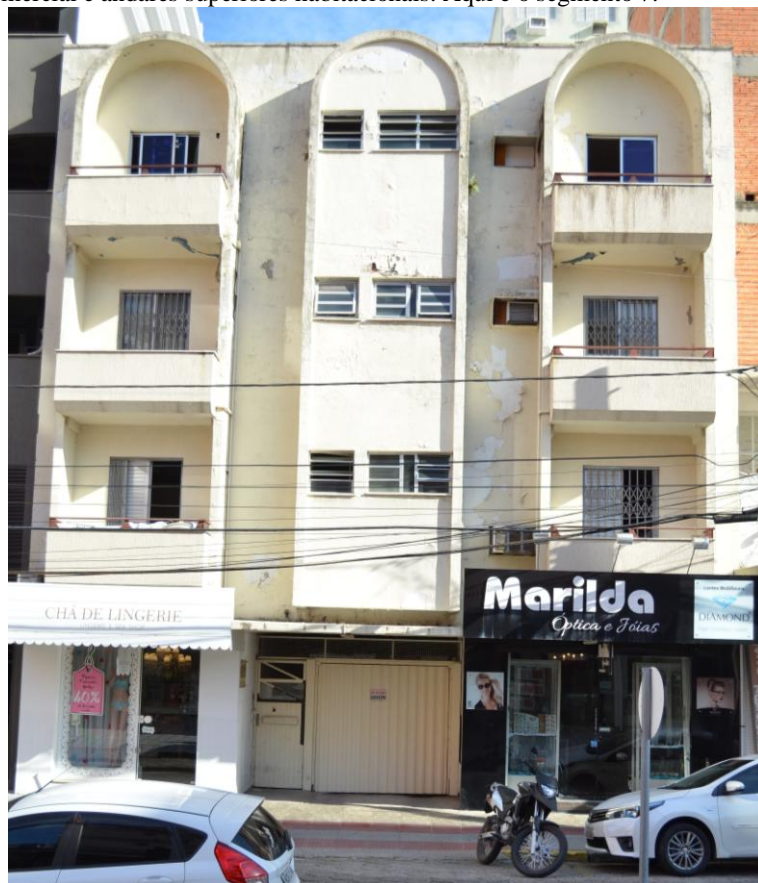
Figura 77 - Exemplo de edificação com uso e constitutividade mista, com térreo comercial e andares superiores habitacionais. Aqui é o segmento 7.
