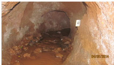
Figura 34 – “Arco romano”, indicando estabilidade do teto do túnel. Fonte: Acervo pessoal.
