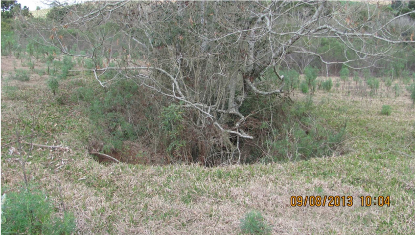
Figura 11 – Estrutura de abatimento com vegetação na encosta Burei. Palmital (PR). Fonte: Acervo pessoal.
