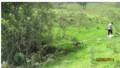
Figura 28 - Entrada de água superficial na estrutura de abatimento principal do túnel. Fonte: Acervo pessoal.
