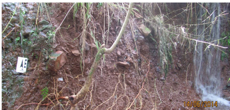
Figura 48 - “Cabeceira” do túnel expando materiais grosseiros em linha; notar água superficial entrando no sistema subsuperficial e linha de seixos com cristais de quartzo.
