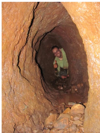
Figura 35 – Teto do túnel estabilizado com processo de entalhe do piso. Fonte: Acervo pessoal.
