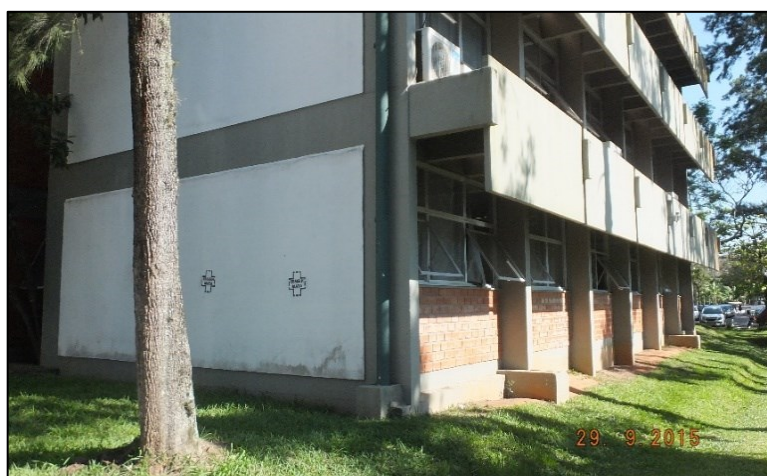
Figura 35 – Fachada convencional com alvenaria aparente - UFSC.
