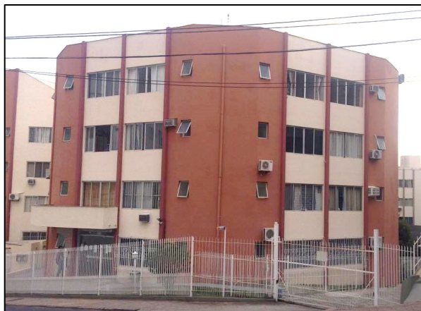
Figura 4 - Exemplo de fachada em alvenaria argamassada com pintura.
