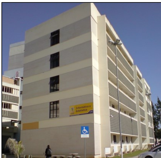
Figura 34 - Fachada convencional - UFSC.
