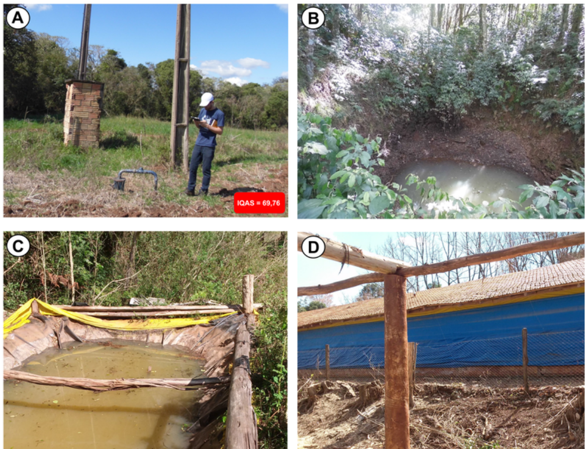
Figura 30. Fotografias tiradas na propriedade onde localiza-se o poço nº 18. A - Poço nº 18 localizado próximo à pastagem e floresta nativa, no qual observa-se a ausência de laje e cerca, resultado do IQAS indicado no canto direito inferior. B - Fonte principal, em encosta, com nível freático a cerca de 2 m de profundidade. C - Cisterna, localizada entre as fontes e o poço, com fundo impermeável mas sem tampa. D - Aviário em operação (nos fundos) e em construção (em frente), instalados abaixo das fontes e cisterna mas acima do poço comunitário.
