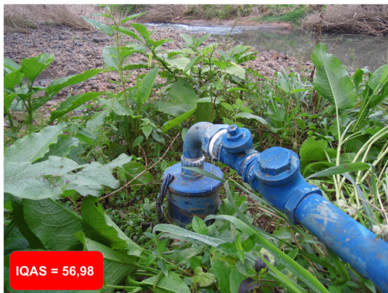
Figura 34. Fotografia do poço n° 95, situado em Nova Teutônia, Seara, evidenciando sua proximidade com o Rio Ariranha (ao fundo) e seus problemas construtivos. No canto esquerdo inferior, o IQAS para 2015.
