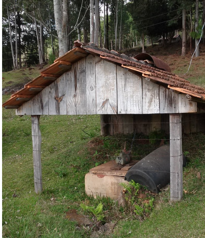
Figura 29. Fonte semelhante ao modelo Caxambu localizada próximo ao poço n° 16.
