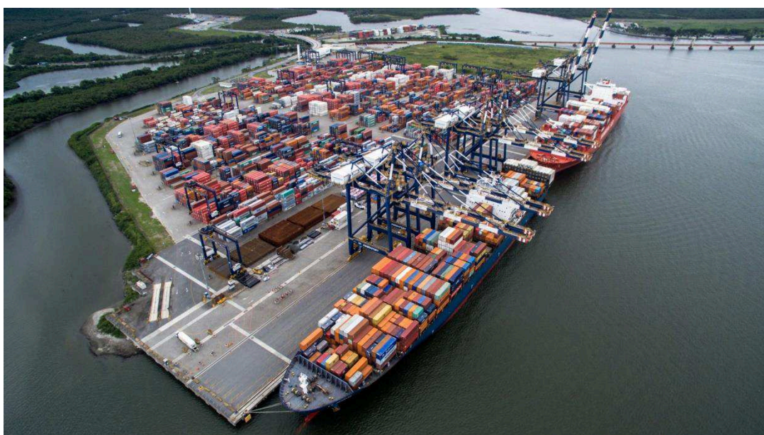
Figura 4 - Terminal Emraport no Porto de Santos
