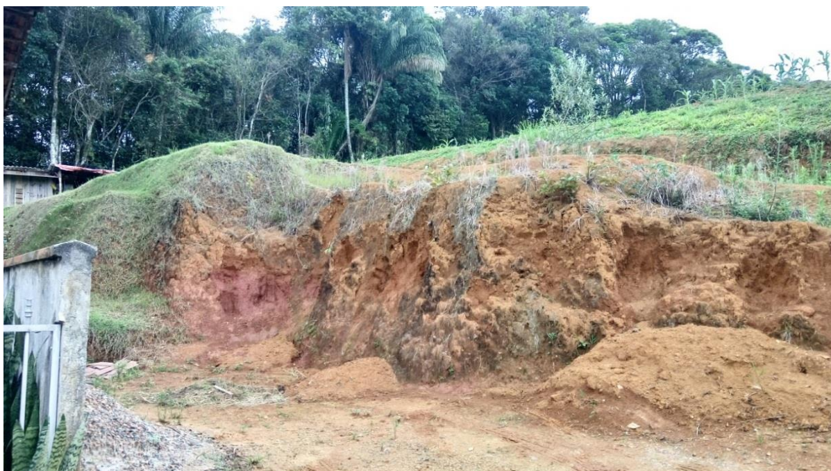
Figura 20 – Encosta Localizada na Rua São Sebastião
