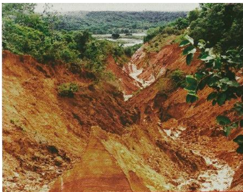
Figura 3 – Voçoroca com profundidade atingindo o horizonte C
