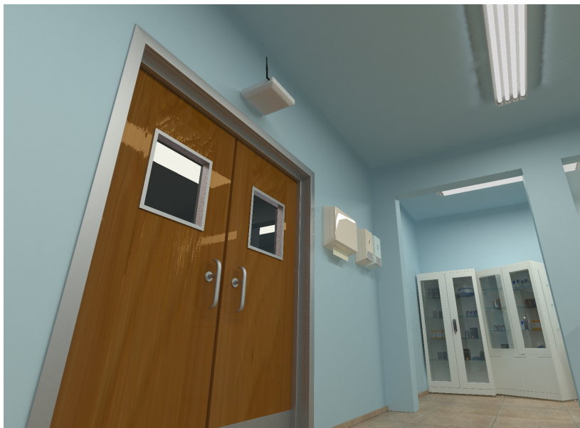
Figura 29 – Antena localizada nas portas e passagens
