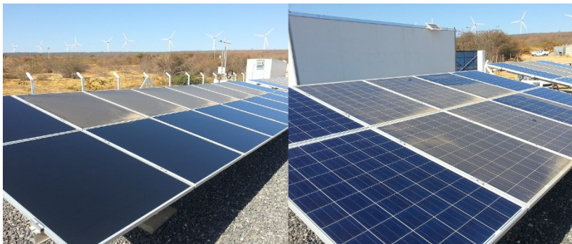
Figura 33 – Comparação entre módulos FV sujos e limpos dos sistemas a-Si/ \mu c-Si (esquerda) e p-Si (direita).
