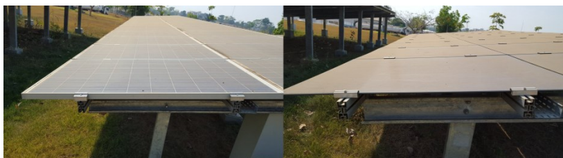
Figura 45 - Subsistemas p-Si (esquerda) e a-Si sem moldura (direita), mostrando o perfil de sujeira aderida. Nota-se a menor concentração de sujeira aderida naquele, e a inexistência neste.
