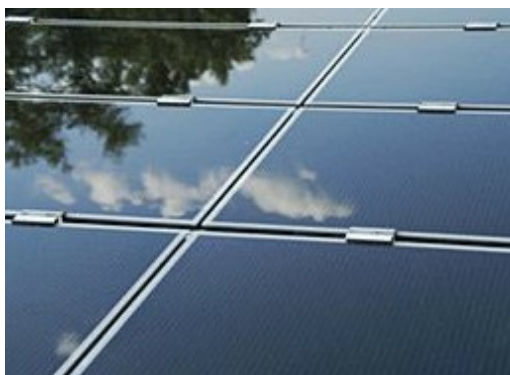
Figura 12 – Exemplo de módulo FV de silício cristalino de 60 células.
