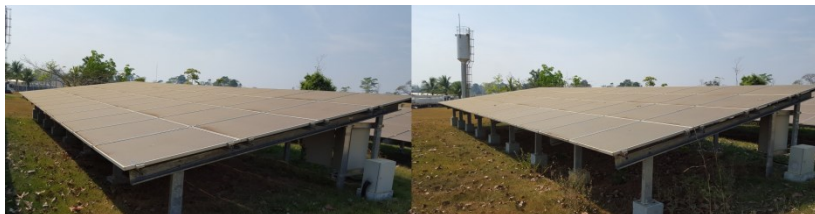
Figura 42 – Subsistemas a-Si (esquerda) e a-Si/ \mu c-Si (direita), exemplificando as mesas com configuração de quatro fileiras de módulos FV horizontais.
