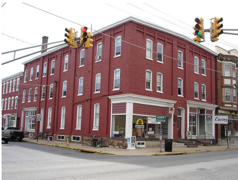
Figura 2 - Na foto, o prédio construído no local do prédio sinistrado.
