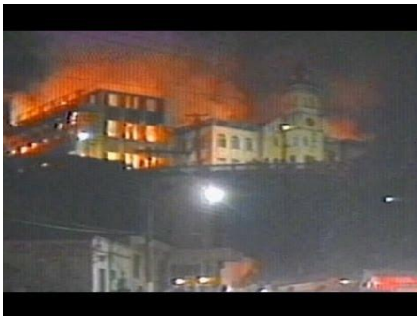
Figura 9 - Incêndio no hospital de Caridade em Florianópolis.
