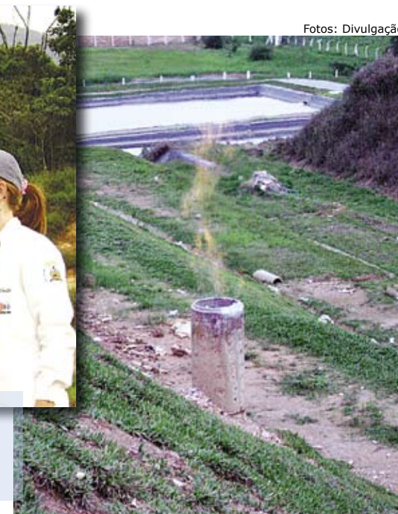
Tubos de concreto - os drenos - fazem a coleta e o tratamento dos gases. Estudantes realizam a medição do volume de biogás
