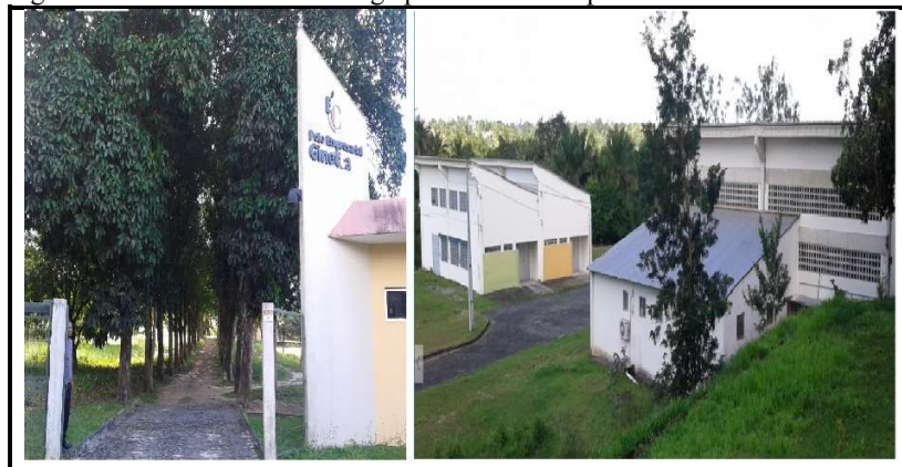
Figura 6 – Vista da entrada e os galpões industriais polo Ginetta
