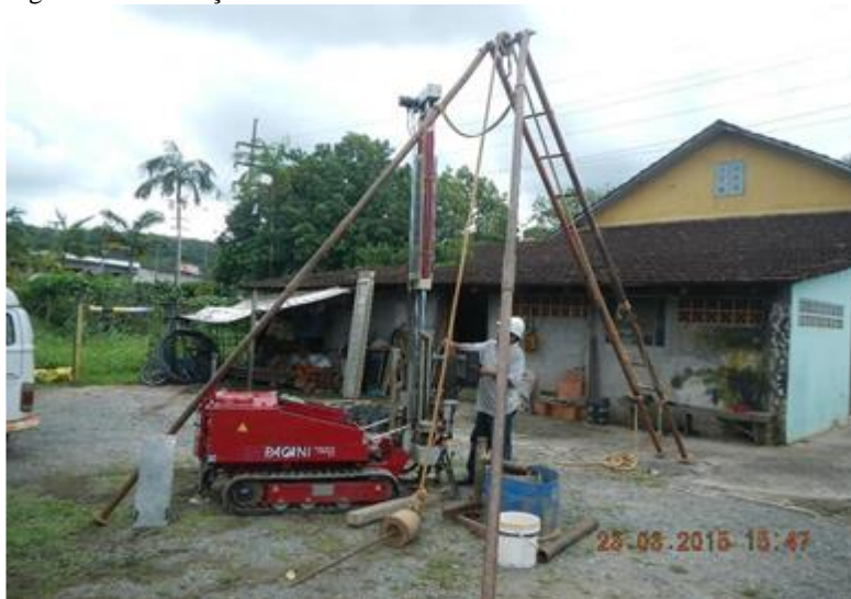
Figura 54 – Execução do DPSH ao lado do furo SPT finalizado.
