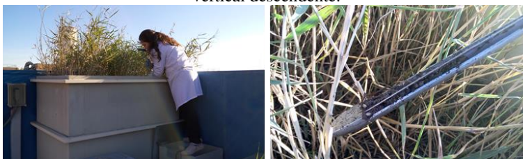
Figura 13 – Coleta de amostras no maciço filtrante do wetland construído vertical descendente.
