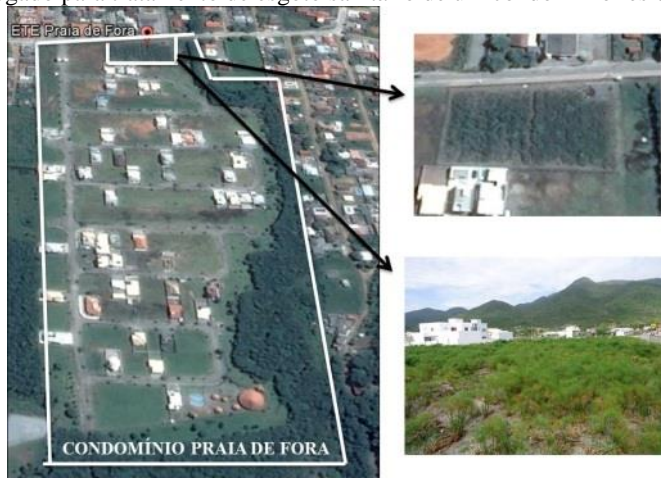
Figura 9 – Wetland construído vertical descendente de fundo saturado empregado para tratamento de esgoto sanitário de um condomínio residencial.
