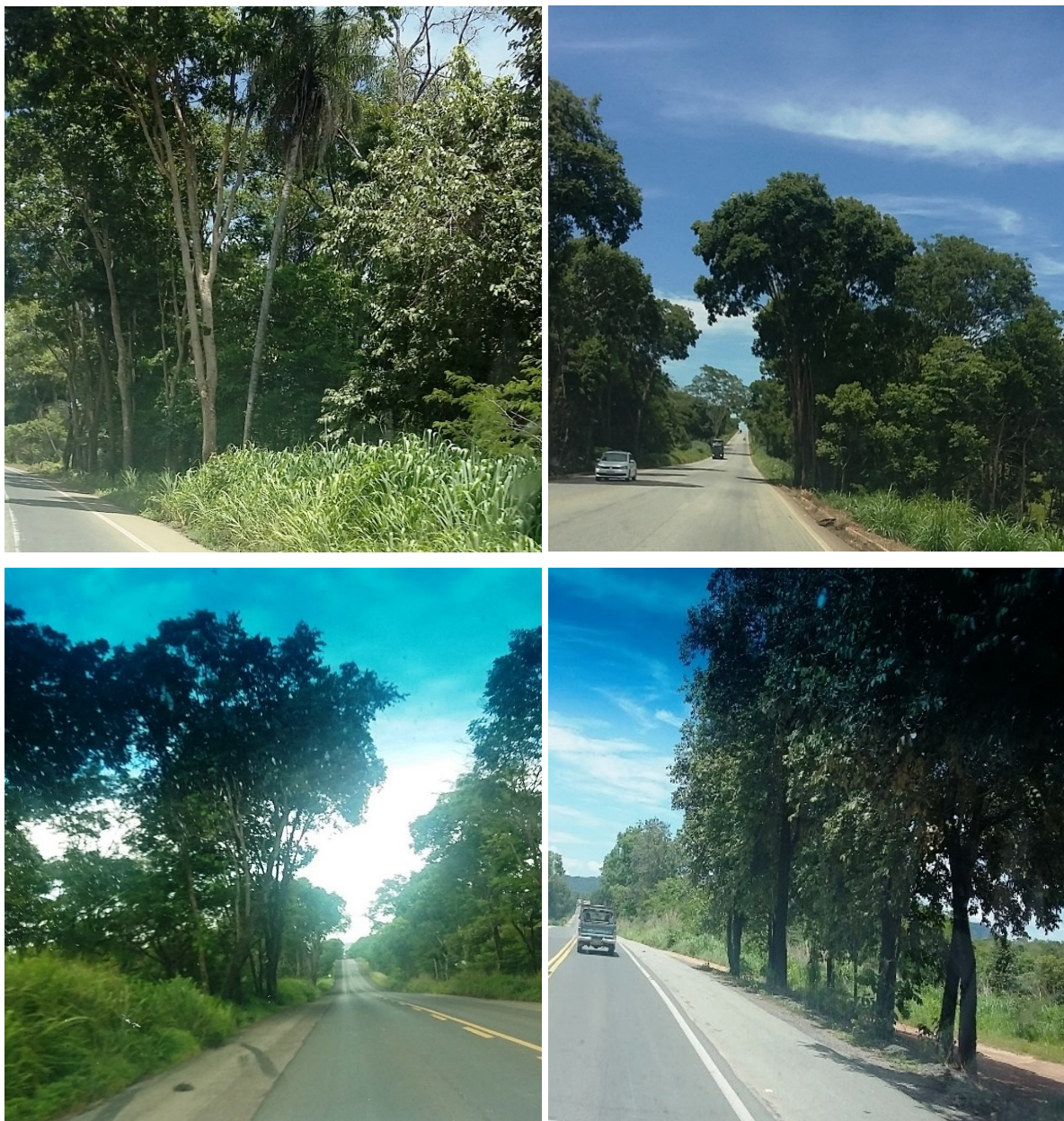
Figura 20 – Imagens de Zonas livre da BR 153/TO sem proteção com dispositivos de contenção
