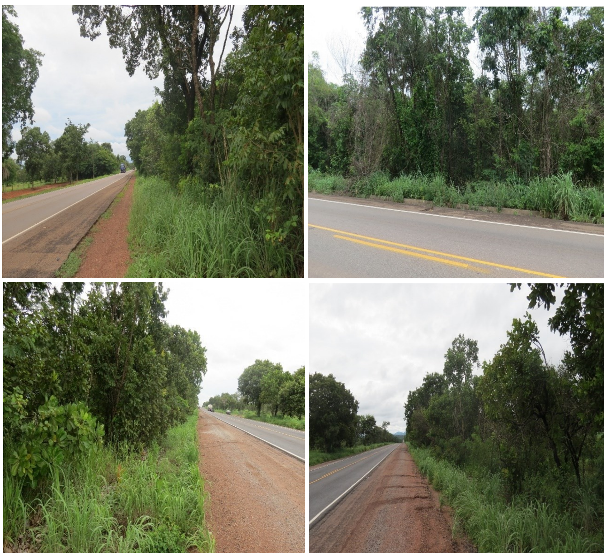
Figura 11 – Vegetação na faixa de domínio da BR-153 – Zona rural de Paraíso do Tocantins
