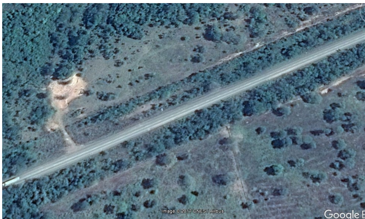
Figura 18 – Imagem da faixa de domínio da BR-153/TO próximo ao km 515,0 (ponto equidistante entre Paraíso e Pugmil).
