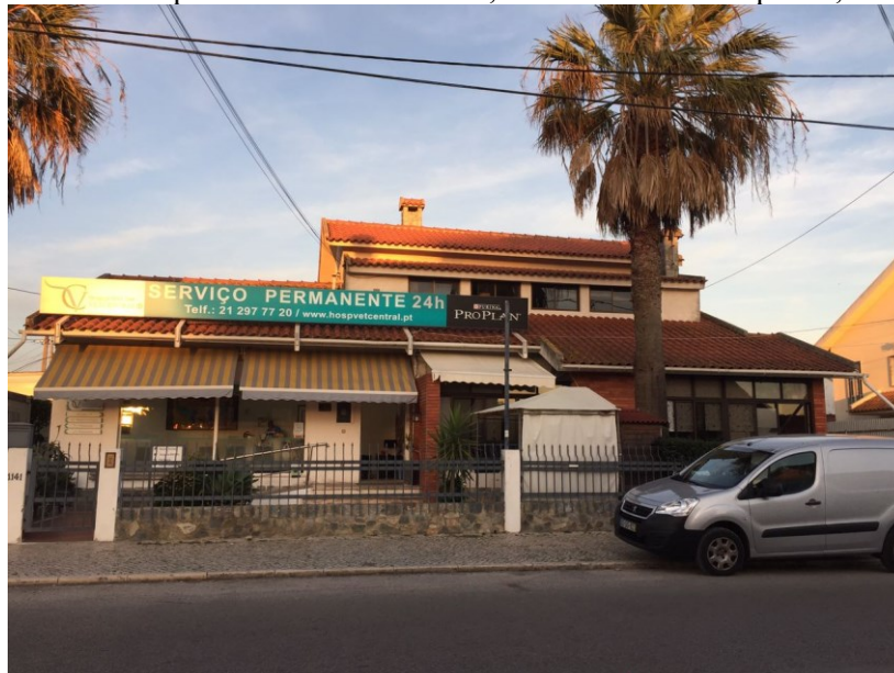
Figura 1– Fachada do Hospital Veterinário Central, em Charneca da Caparica, Setubal, Portugal.
