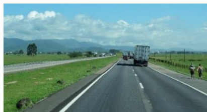
Figura 415: Pistas separadas por biovaleta, áreas laterais da estrada cercadas no município de Tijucas, BR-101/SC. Pedestres no acostamento. Fonte: Angela Favaretto, 2012.
