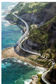
Figura 190: Vista superior Sea Cliff Bridge na Great Ocean Road . A estrada apoia pista em alguns pontos da encosta onde o relevo favorece. No restante sobre estrutura de pilotes.
