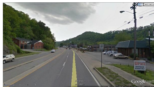
Figura 121: 2 - Área urbanizada, uso predominantemente de serviço. A estrada adota desenho diferente do que quando passa em área não urbanizada, suprimindo barreira central, adicionando calçada e acesso ao pátio frontal das edificações. Fonte: Angela Favaretto, a partir do Google Earth, 2016.
