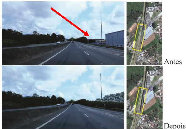
Figura 423: Minimização de visual para empresas/fábricas. Logo depois do acesso a Pirabeiraba, Joinville-SC. Fonte: Angela Favaretto, 2017, a partir de acervo pessoal e Google Earth, acesso jan. 2017.
