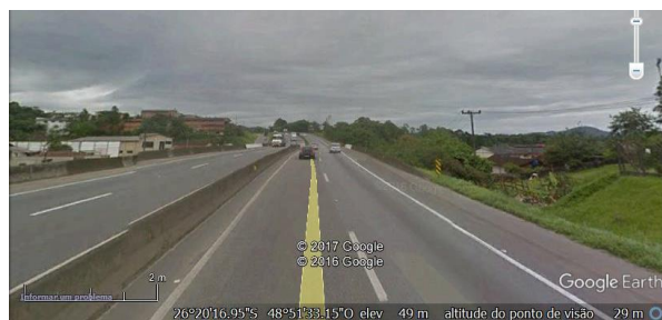
Figura 292: BR-101/SC em área urbana de Joinville, sobre viaduto que faz a continuação de um rua urbana que está em nível inferior que a BR-101.
