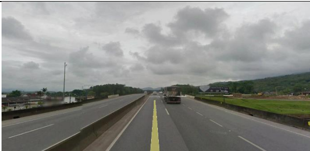
Figura 277: BR-101/SC em Garuva deslocamento Norte/Sul. A área urbana fica visível (esquerda), já que a BR-101 está elevada devido ao viaduto que conecta seus dois lados. Fonte: Angela Favaretto, a partir de Google Earth, 2016.
