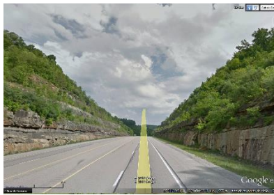
Figura 130: Vista a partir da estrada. Destaque para retaludamento da encosta.
