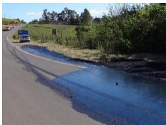
Figura 18: Derramamento de líquido tóxico Rodovia Jurandir Siciliano (SP-255). Itaporanga (SP).
