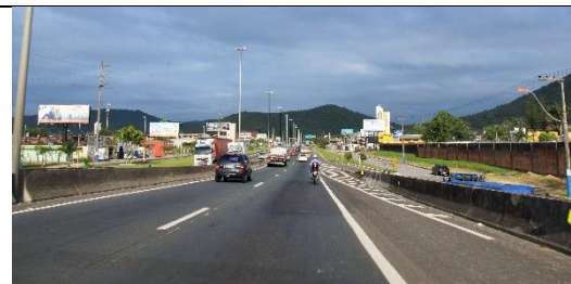
Figura 318: 1 - BR-101/SC em Balneário Camboriú logo após passar trecho densamente urbanizado. Deslocamento sul-norte. Ao fundo, as morrarias costeiras fecham a visual, contrastando o edificado com o natural.
