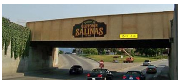
Figura 83: Pannel de identificação de comunidade sobreposto a uma passagem superior (viaduto) existente na Route 183 em Monterey County.
