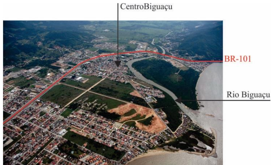
Figura 360: BR-101/SC em Biguaçu, área central. Rodovia assentada em planície e transpassando o rio Biguaçu. Fonte: Prefeitura Municipal de Biguaçu, 2005.
