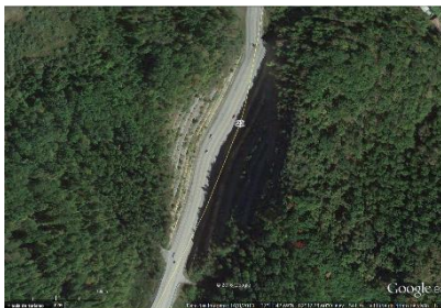
Figura 129: Imagem aérea da Country Music Highway em Jenkins. Destaque para retaludamento da encosta.
