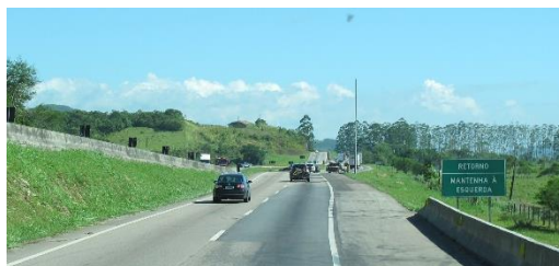
Figura 420: Divisa Biguaçu e Tijucas. Publicidade na borda da estrada contrastando com aspectos naturais. Situação hipotética com a retirada da placa. A visual livre favorece para que a silhueta do morro seja percebida e não desvie a atenção.
