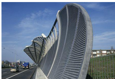
Figura 44: Barreira acústica também gera energia a partir de placas fotovoltaicas. A16 próxima de Dordrecht , Holanda.
