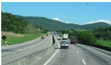
Figura 414: Divisão de pistas por blocos de concreto, barreira tipo New Jersey no município de Biguaçu, BR-101/SC Fonte: Angela Favaretto, 2012.
