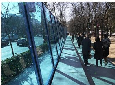
Figura 42: Barreira acústica transparente propicia integração visual.
