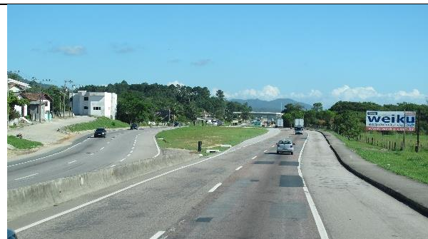
Figura 345: 3- BR-101/SC em Biguaçu, Comunidade de Tijuquinhas. Deslocamento sul-norte.
