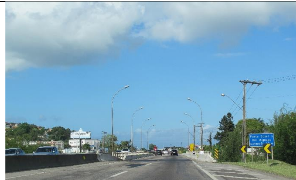
Figura 359: 1 – BR-101/SC, ponte sobre rio Biguaçu. Olhando em planta, nota-se bastante proximidade com o mar, mas não há visão para o mar pela curva vertical do traçado, que direciona a visão para cima, enquanto o mar está para baixo. Fonte: Angela Favaretto, 2012.
