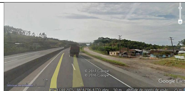
Figura 302: 1 - Balneário Piçarras. Deslocamento sul-norte. Ocupação urbana nas margens da rodovia, com via marginal sem pavimentação. Ao fundo da imagem passarela.
