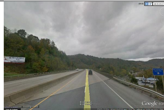
Figura 116: 1 - Deslocamento na Country Music Highway , Whitesburg, no viaduto que transpõe o rio Levisa e a cidade de New Allen que está no vale. A ocupação é pouco vista a partir da estrada, já que a paisagem urbana é mais horizontal e se encontra abaixo do nível da rodovia. Fonte: Angela Favaretto, 2016, a partir do Google Earth, 2016.
