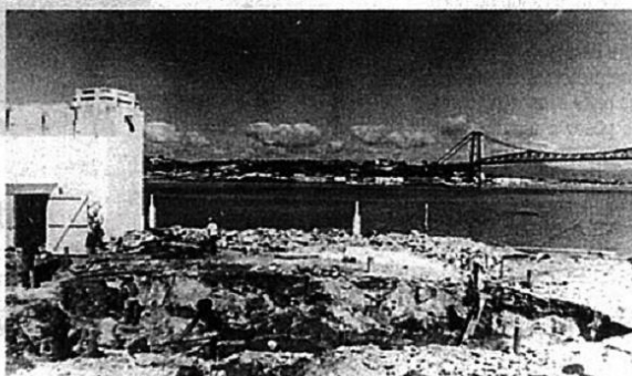
Trabalhadores preparam a ilha para receber estrutura da Colombo Salles
