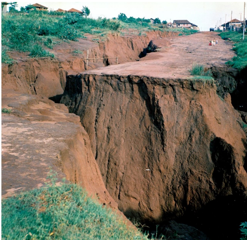
Figura 17 – Vossoroca destruindo estrada de rodagem . Mandaguaçu, Paraná, Dezembro 1958. Kodacolor – filme negativo. Foto: Armínio Kaiser.
