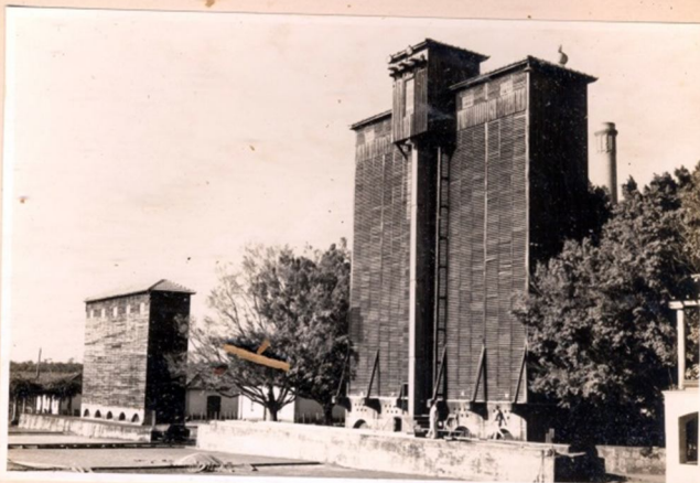
Figura nº 32 - Esse secador de café é provavelmente o maior do Brasil, ou mesmo do mundo no gênero. Notar a chaminé da fornalha ao lado direito da fotografia.
