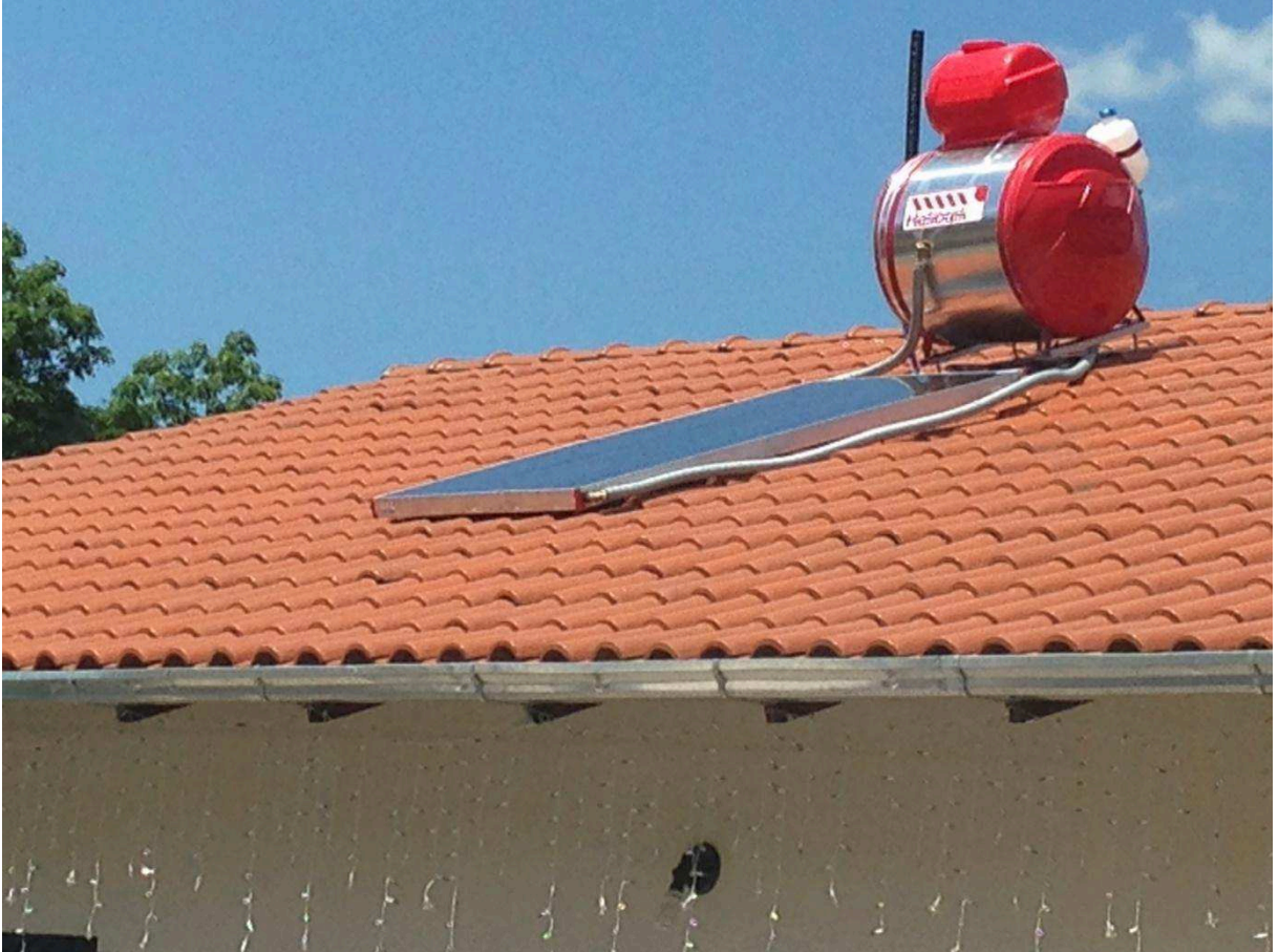
Figura 15 – Imagem do sistema instalado.
