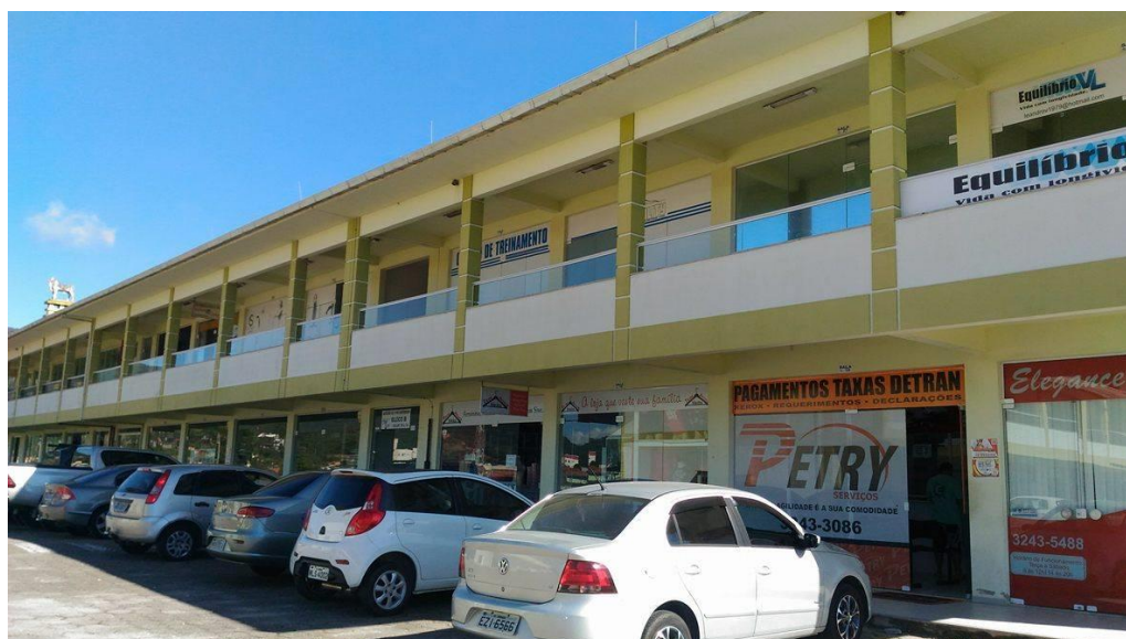
Figura 21: Fachada frontal do Bloco B
