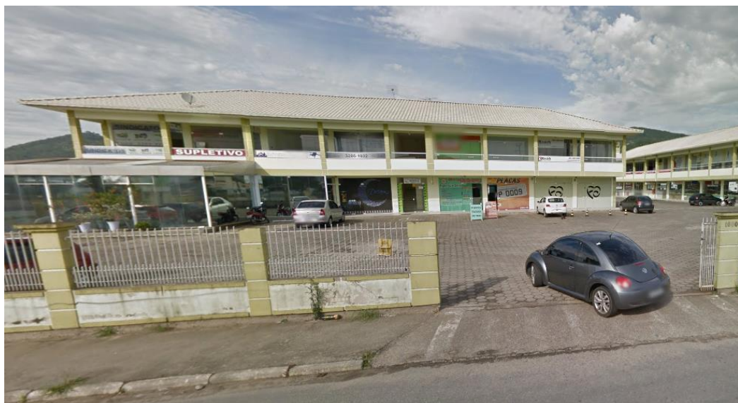
Figura 20: Fachada frontal do Bloco A
