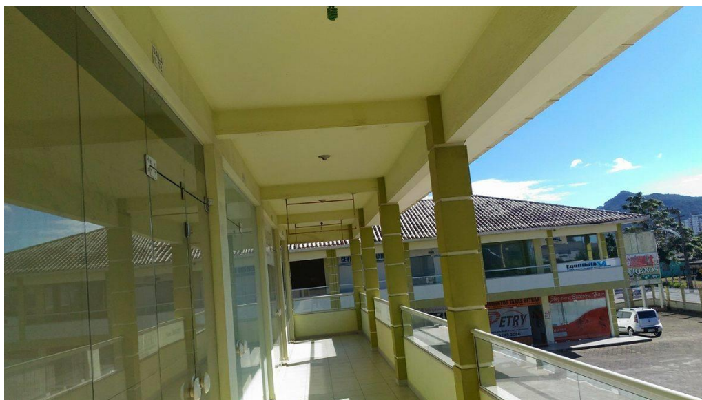
Figura 25: Área de circulação do pavimento superior do bloco A
