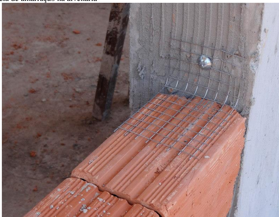
Figura 11 - Tela de amarração na alvenaria
