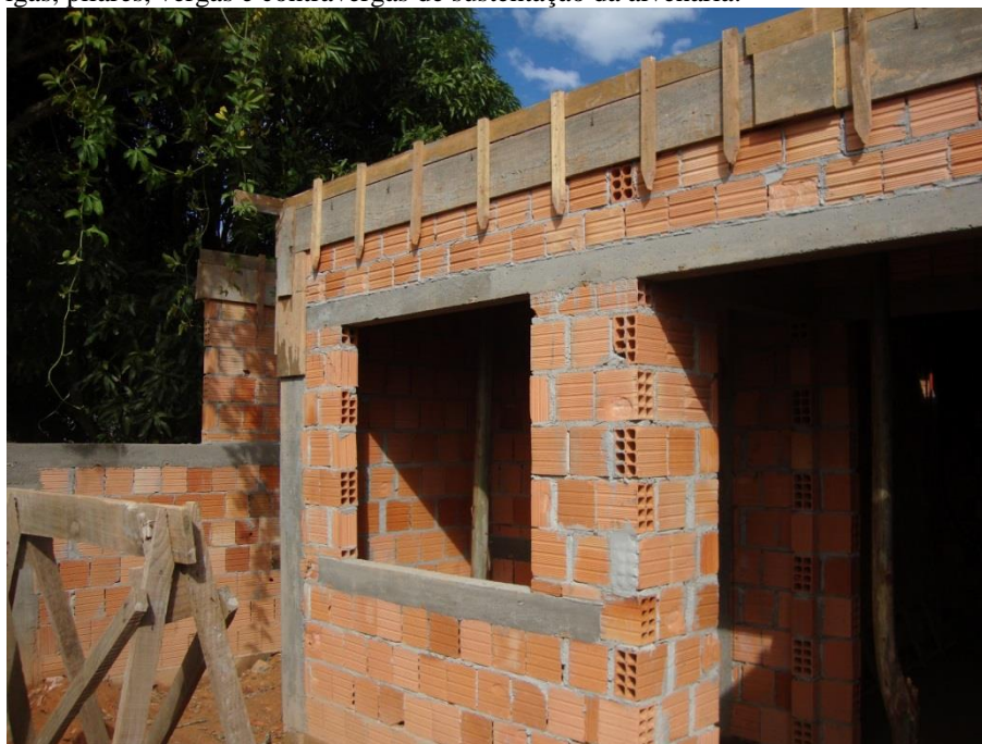
Figura 12 – Vigas, pilares, vergas e contravergas de sustentação da alvenaria.
