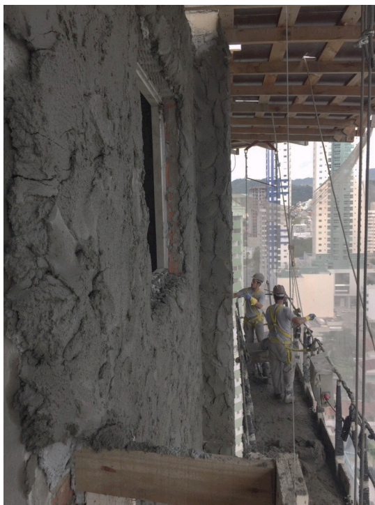
Figura 13 - Oficiais trabalhando sobre o balancim durante a execução da segunda camada.
