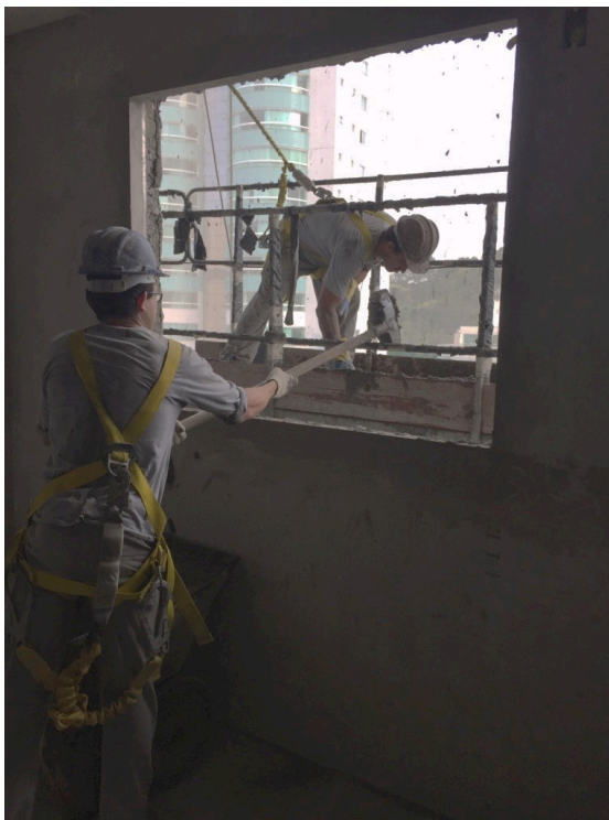
Figura 12 - Ajudante alcançando argamassa para o oficial sobre o balancim.
