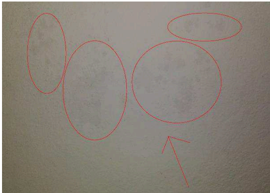
Foto 17: Parede externa do banheiro, no corredor, ala 7.
