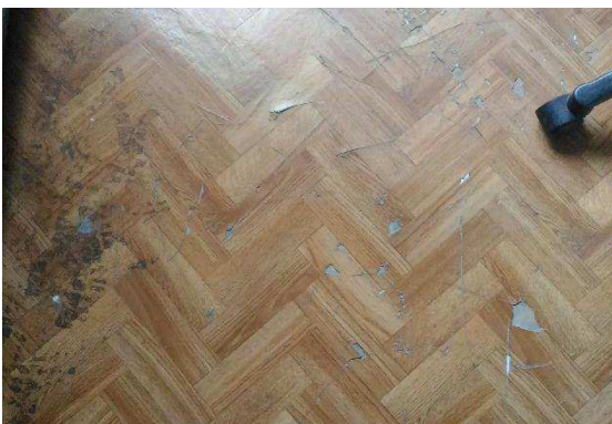
Foto 4: Piso na área de computadores, ala 1.
