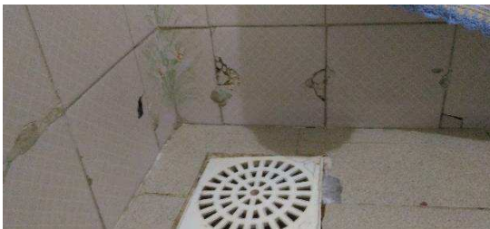
Foto 22: Chuveiro, banheiros antigos de várias alas.
