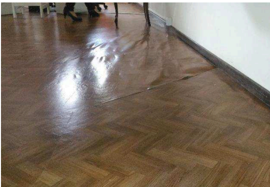
Foto 3: Piso abaixo da escada lateral, ala 1.
