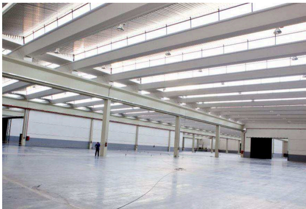
Figura 3 – Instalação industrial executada em elementos pré-fabricados.
