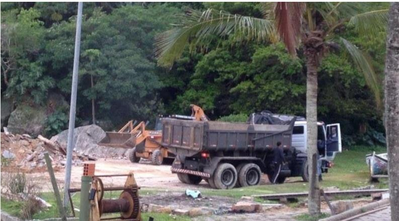
Figura 30 - Remoção dos entulhos da demolição. Foto: Rodrigo Bittencourt, 2016.
