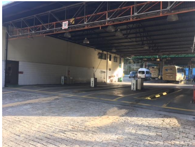
Figura 9 – Espaço de abastecimento
