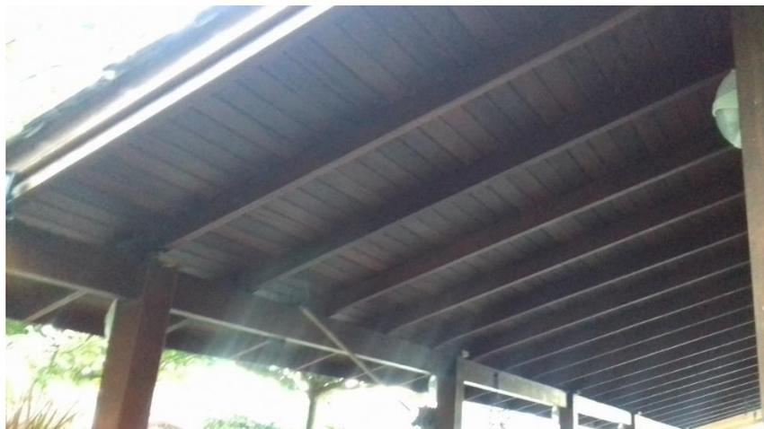
**Figura 27** - Estrutura da cobertura da residência 1.
