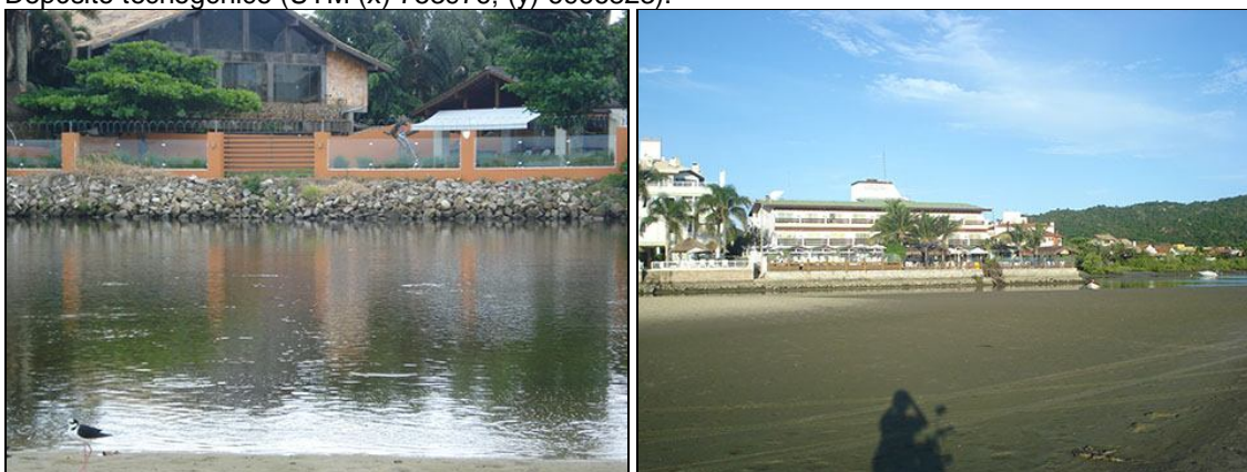
Figura 36: Estabilização da erosão por enrocamentos rochosos alóctones, caracterizando um Depósito tecnogênico (UTM (x) 753976; (y) 6966823).
