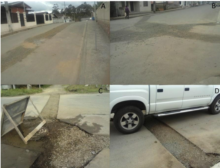
Figura 8: Nas figuras A, B e C, demonstra o aspecto estético negativo causado após a execução da rede coletora de esgotos pelo método convencional de abertura de valas. Na figura D, nota-se que há uma tendência o tráfego ficar mais lento (Fonte: Elaborado pelo autor).
