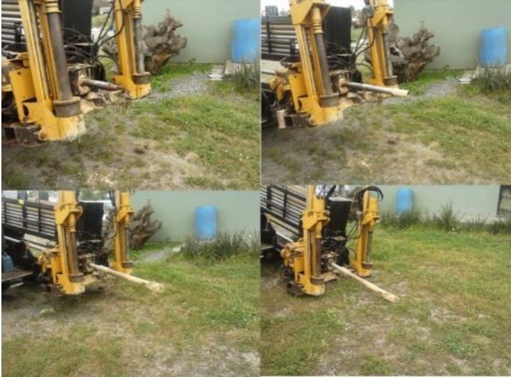
Figura 20: Princípios de funcionamento da perfuratriz direcional com a haste, acoplamento da cabeça de furação às hastes e início do furo pilo em solo silto-argiloso (Fonte: Elaborado pelo autor).
