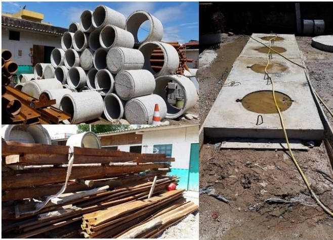
Figura 2: Armazenamento de materiais. (Fonte: Elaborado pelo autor).
