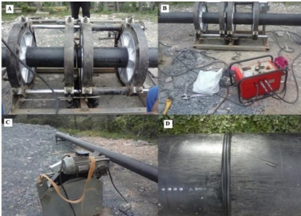
Figura 16: Na figura A (canto superior esquerdo) é apresentado a estrutura básica para apoiar a junção das duas tubulações, na figura B (canto superior direito), o termofusor e a estrutura básica já com as duas tubulações juntadas, na figura C (canto inferior esquerdo) está o motor para controlar o termofusor, e na figura D (canto inferior direito) está o resultado da solda das duas tubulações de PEAD (Fonte: Elaborado pelo autor).
