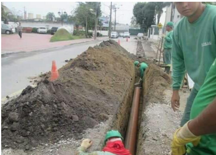
Figura 6: Rede coletora de esgoto sendo assentada (Fonte: Elaborado pelo autor).
