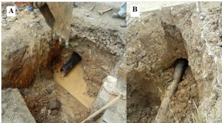
Figura 24: Poço de desemboque e emboque, figura A e B, respectivamente. Nota-se que o fluido está escoando para o poço de desemboque através do teste de escoamento.
