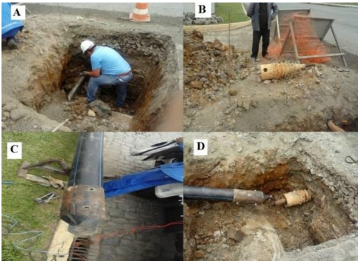
Figura 23: Figura A, operador tirando excesso de solo da pá de perfuração e na ponta da haste. Figura B, representa o alargador necessário para o diâmetro de 225mm. Figura C, cabeça de puxamento para aplicação na perfuração direcional dirigida. Figura D, alargador com a cabeça de puxamento e a tubulação pronto para o “pull-back” (Fonte: Elaborado pelo autor).
