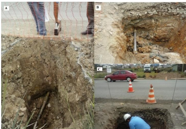
Figura 22: Figura A, haste iniciando a perfuração dirigida no poço de emboque e operador acompanhando até um certo trecho com o transmissor, para ter a garantia de que atingirá a declividade requerida. Figura B, perfuração dirigida realizada atingindo o poço de serviço de desemboque, são apresentados a pá de perfuração e a ponta da haste. Figura C, tamanho geral da travessia, rente a Rodovia SC-114 (Fonte: Elaborado pelo autor).
