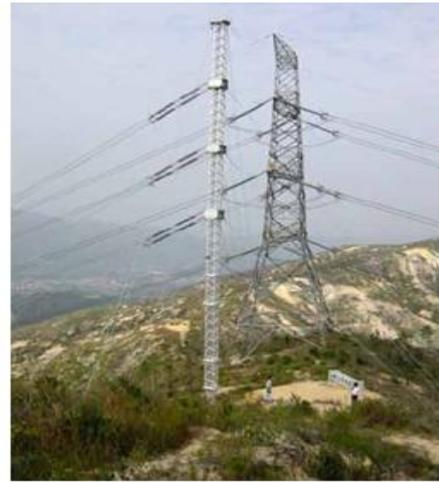
Figura 10: Torre de transmissão de energia elétrica acidentada e a aplicação de uma torre de emergência em campo (no Canadá)
