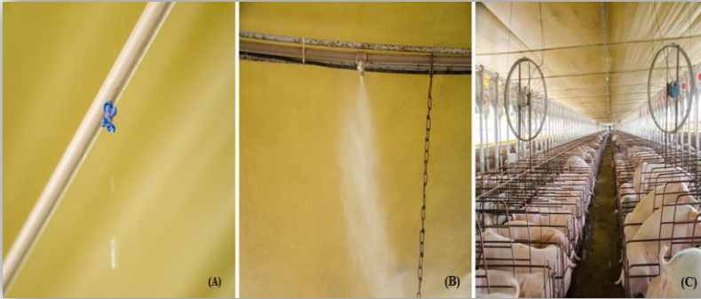
Figura 6: Mecanismos de resfriamento evaporativo: (A) Gotejamento; (B) Nebulização por aspersão; (C) Ventilador mecânico.
