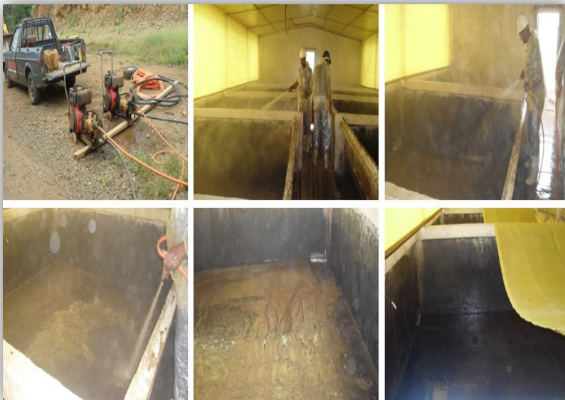
Figura 7: Limpeza por via úmida tendo como recurso a bomba de alta pressão/baixa vazão.
