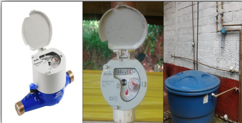
Figura 16: Hidrômetro e a sua instalação nas linhas de abastecimento de água.
