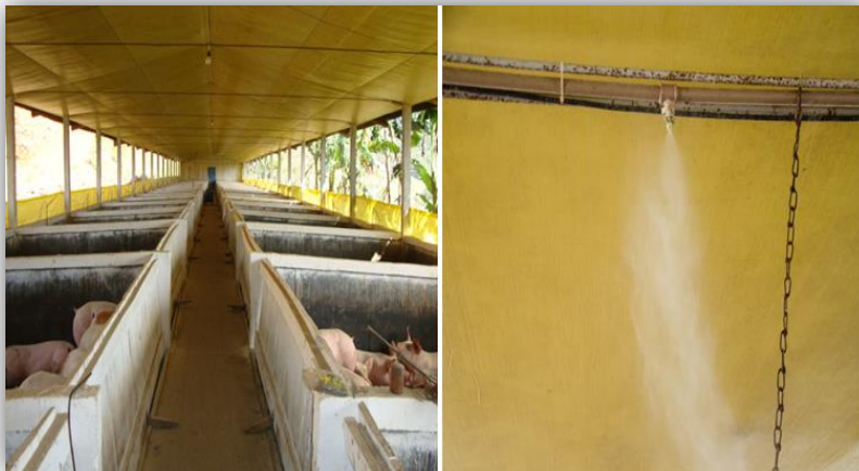
Figura 18: Instalação da linha de abastecimento de água do mecanismo de resfriamento evaporativo, bem como o funcionamento de um nebulizador.
