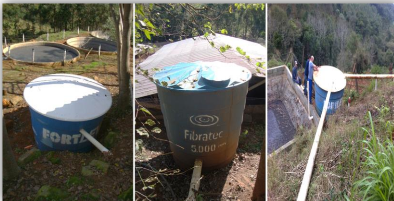
Figura 20: Caixas de fibra de vidro para determinação do volume total de dejetos produzidos.
