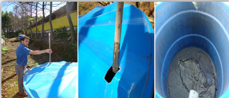
Figura 21: Procedimento de leitura da altura da lâmina de água dos dejetos produzidos e o acúmulo de sólidos observado no fundo das caixas.
