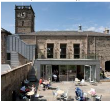
Figura 36: Acréscimo de escada externa para rota de emergência
