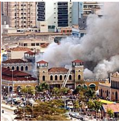
Figura 20: Incêndio no Mercado Público, Florianópolis/SC
