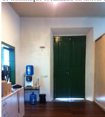
Figura 88: Placa de iluminação localizada na lateral do vão de abertura
