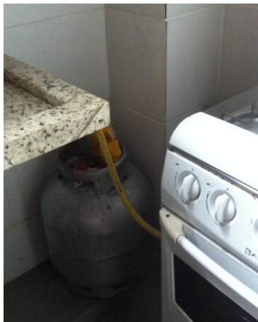
Figura 90: Botijão de gás localizado no interior do salão
