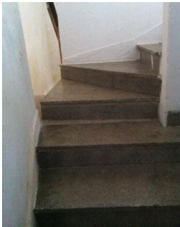
Figura 80: Escada de acesso ao mezanino
