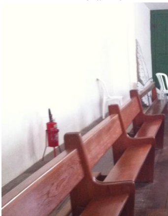
Figura 81: Extintor localizado no Mezanino
