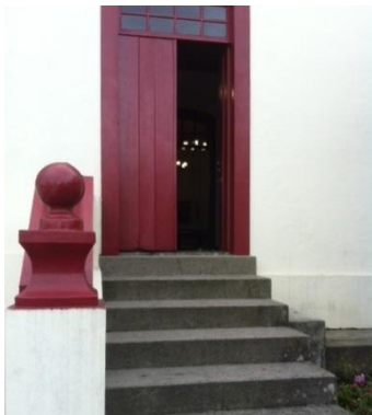
Figura 55: Porta com acesso ao quintal do terreno
