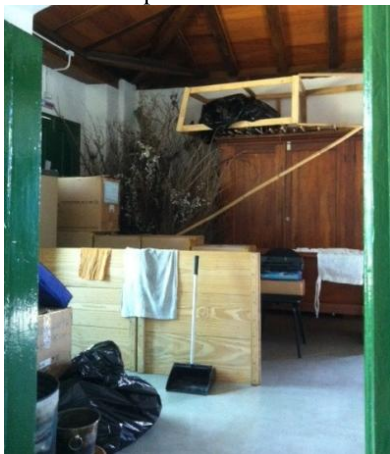
Figura 89: Objetos na sala de depósito impedem a saída
