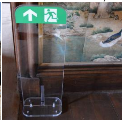
Figura 37: Sinalização sem interferência física na edificação
