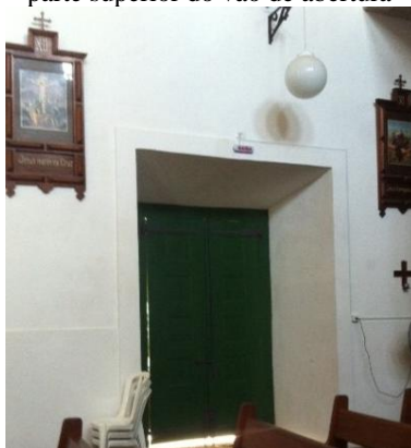
Figura 87: Placa de sinalização na parte superior do vão de abertura
