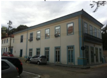
Figura 73: Biblioteca Pública (pavimento térreo) e Fundação Municipal de Cultural (pavimento superior)
