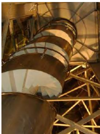
Figura 31: Escada helicoidal de acesso à coroa.
