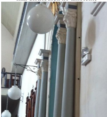
Figura 86: Iluminação de aclaramento mal distribuída no ambiente
