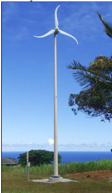
Figura 48 – Torre Eólica Geradora composta por aerogerador SkyStream Land 3.7
