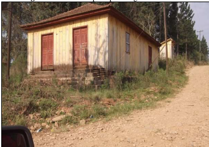
Figura 11 – Casa ocupada por antigos trabalhadores
