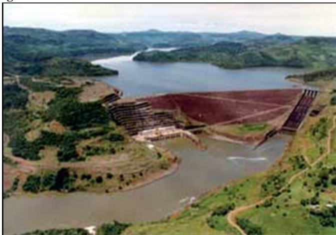
Figura 25 – Hidrelétrica Governador Bento Munhoz da Rocha Netto
