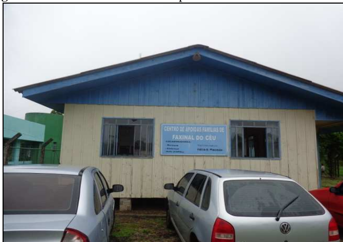
Figura 37 – Fachada do Centro de apoio às famílias de Faxinal do Céu
