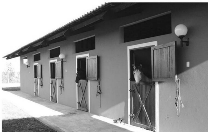
Figura 2: Baias de alvenaria.
