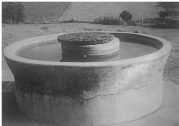
Figura 24: Cocho d'água em alvenaria com boia no centro.
