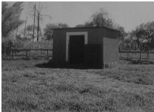
Figura 22: Abrigo na pastagem.
