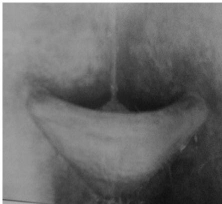
Figura 6: Cocho no canto para facilitar a limpeza, porém com cantos vivos.
