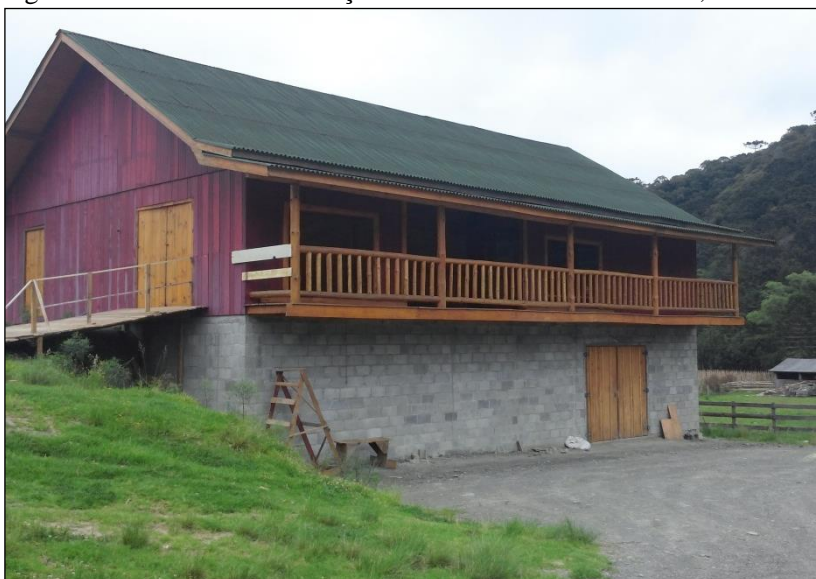
Figura 41: Cantina em construção da Vinícola Casa Cervantes, Urubici.
