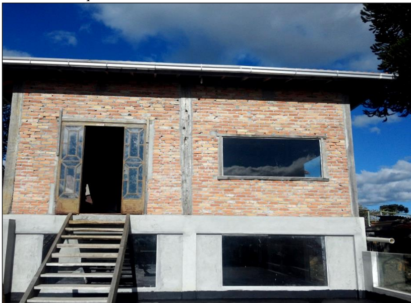
Figura 55: Construção da Cantina e restaurante da Vinícola Villaggio Conti, São Joaquim.
