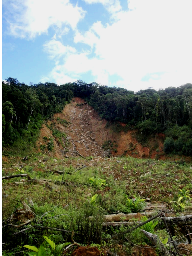
Figura 41. Cabeceira do deslizamento entre Ascurra e Rodeio. Foto: Fernando Schmitt (2011).
