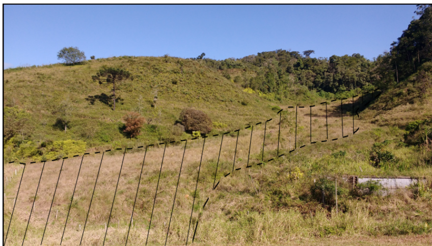
Figura 35. Caminho percorrido pelo deslizamento encosta abaixo. Foto: I. Coutinho, 2016
