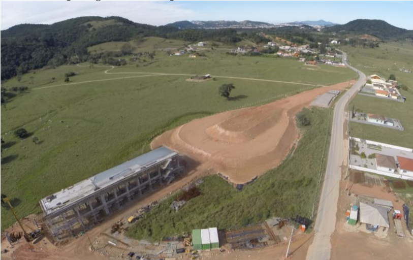
Figura 14 - Obras da alça viária da BR-101, no município de São José, alterando a paisagem de áreas predominantemente residenciais.
