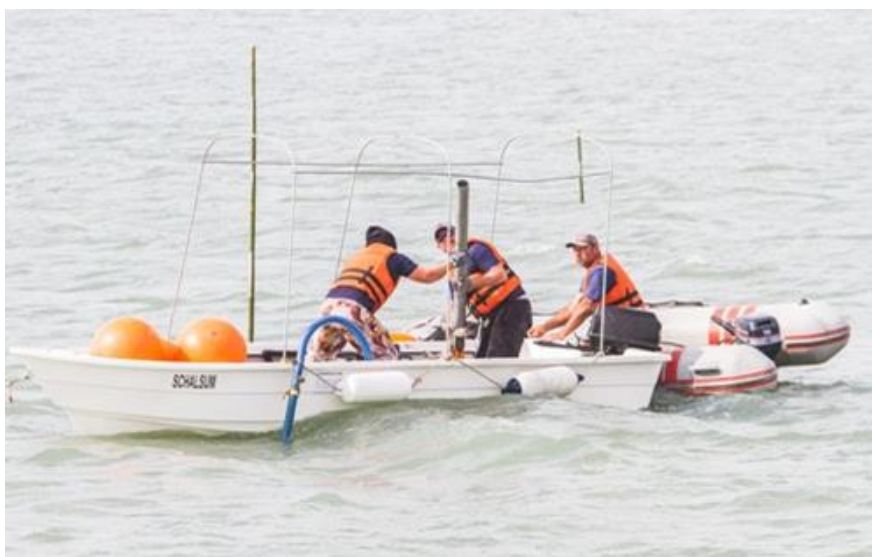
Figura 5 - Instalação das Boias Demarcatórias
