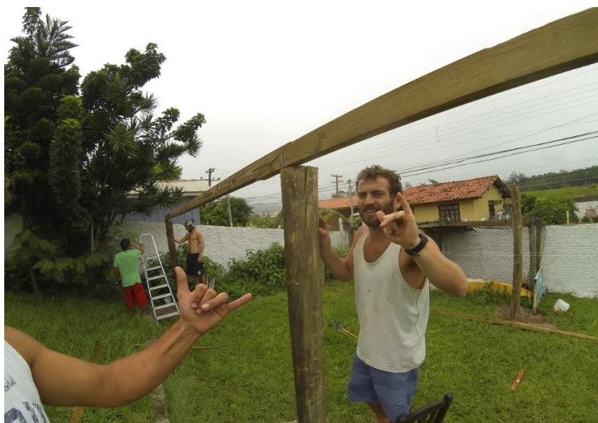
Figura 7 - – Início da construção da estrutura da estufa
