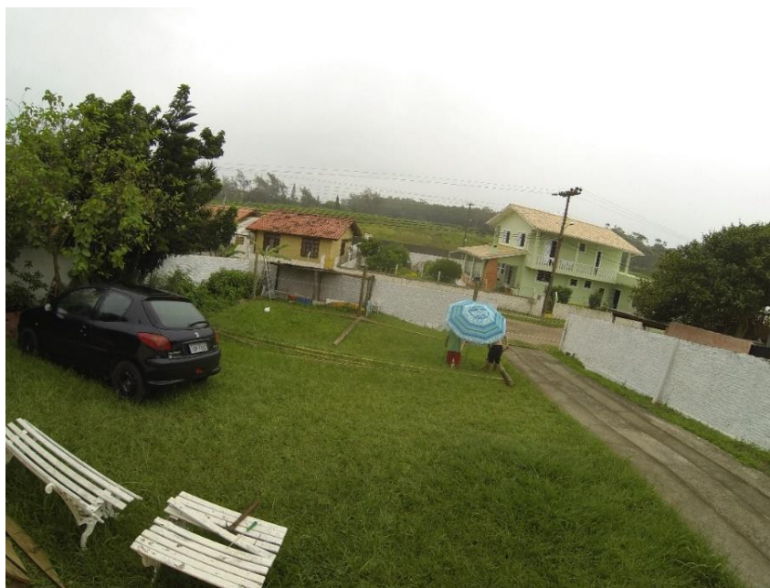
Figura 6 - – Início da construção da estrutura da estufa
