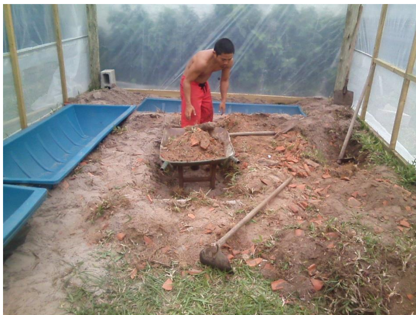
Figura 9 - Durante a escavação para colocação dos tanques
